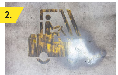
2. Farbentferner aufsprühen, 5 bis 30 min. einwirken lassen
